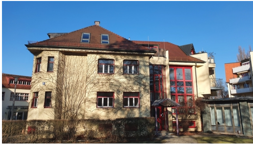
Ostansicht Bauteil E vor Abbruch
